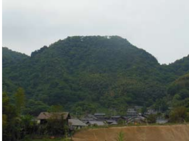
4. 青陰城跡 広島県史跡 尾道市因島町中庄 The ruins of Aokage Castle, Onomichi City
