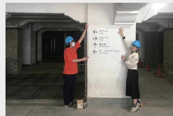
原寸モックアップを作成し、現地にて確認・調整する
