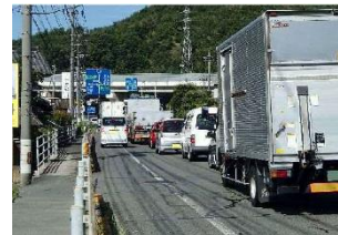
▼市内の幅員の狭い道路
