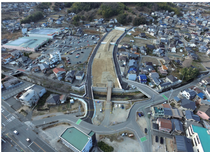
国道 184 号バイパス整備
