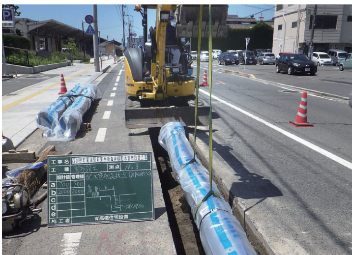
水道施設（老朽管更新）耐震化工事
