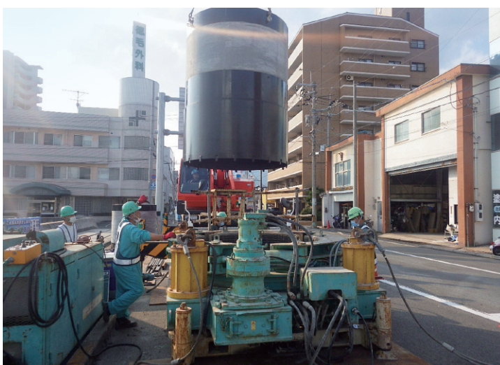
公共下水道工事
