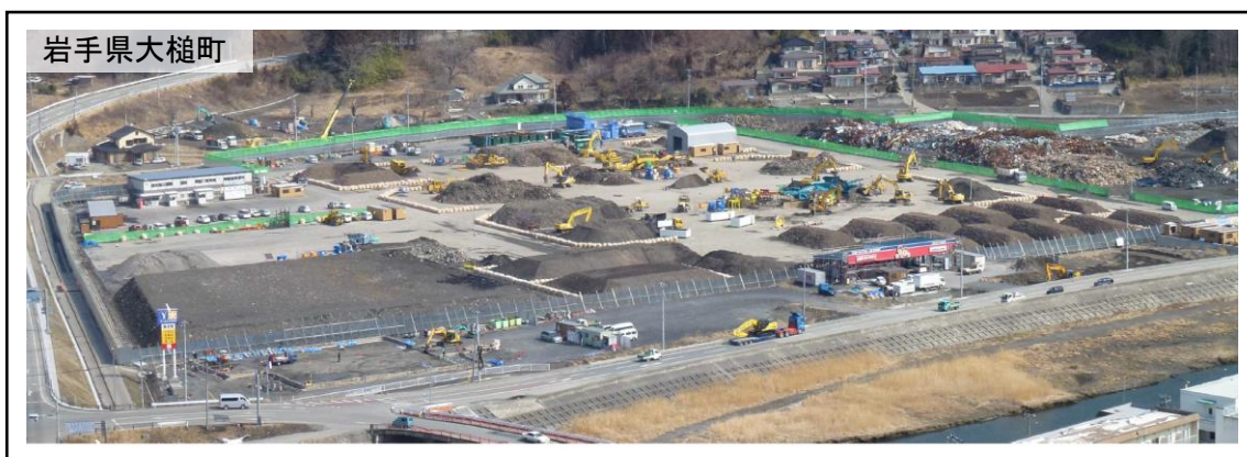
図 2.2.8 二次仮置場の例
