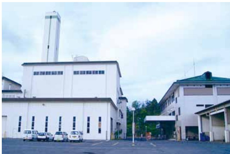
尾道クリーンセンター
