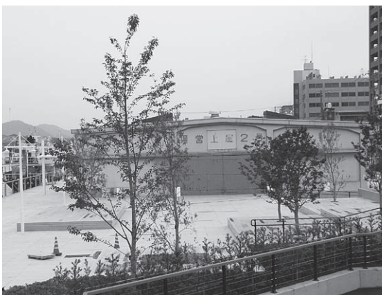
整備中の県営上屋2号倉庫
