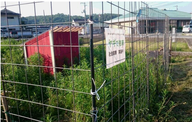
【高さ2mのワイヤーメッシュ(溶接金網)で四方を囲む(上図)】
