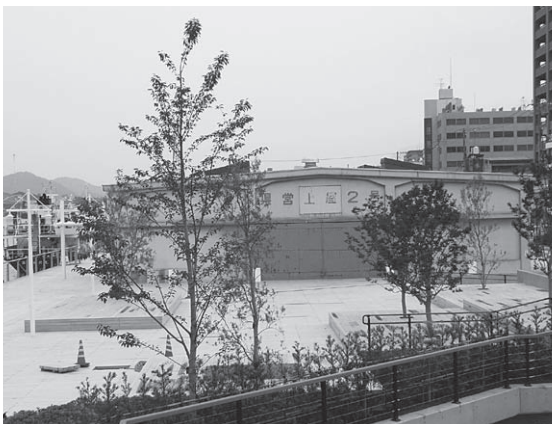
整備中の県営上屋2号倉庫
