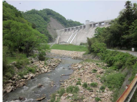
福富ダム（沼田川水道用水供給事業）
