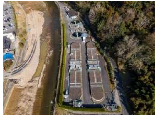
御調町中央浄化センター
