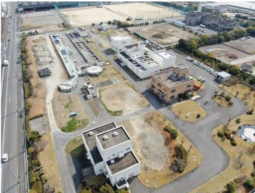
尾道市浄化センター
