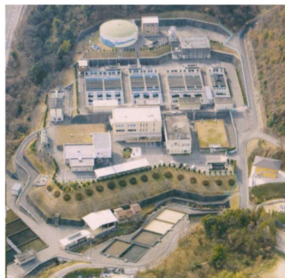
坊土浄水場（沼田川水道用水供給事業）
