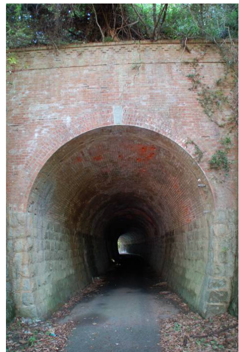
旧尾道鉄道のトンネル
