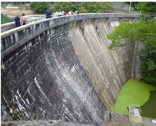
久山田貯水池堰堤
