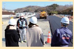
雨の日、タイヤと路面の間に水の膜ができ、スリップ事故の原因となる、ハイドロプレーニング現象が起こりにくい、排水性の良い舗装を敷設しています。
