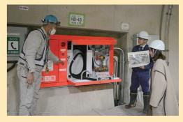
2本あるトンネルの総延長は約2.2kmと、開通 区間の約6割を占めます。車両火災発生時に確 実に放水できるよう、50mおきに消火設備を 配置しています。
