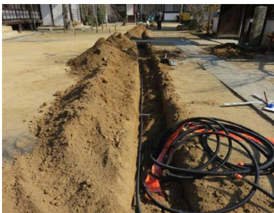
防災設備配管の敷設状況
