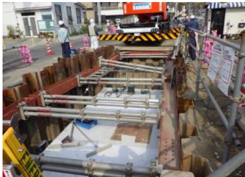
工事状況写真
