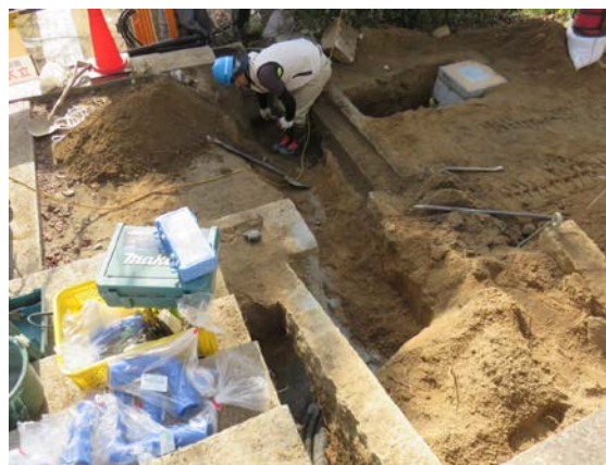
防災設備配管の敷設状況
