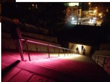
平成29年度整備箇所(浄土寺石段照明)
