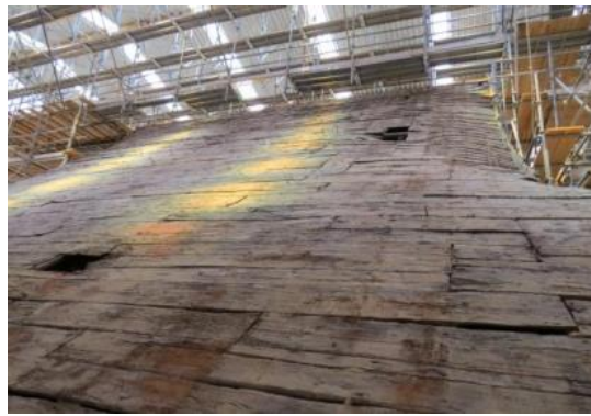
常称寺本堂（重要文化財）の解体修理
