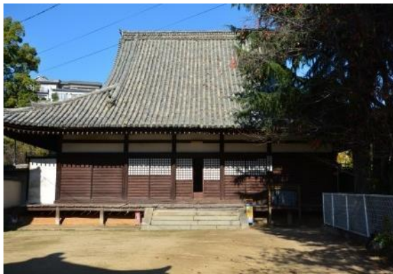
常称寺本堂 (重要文化財)
