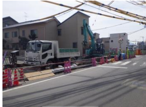
工事状況写真
