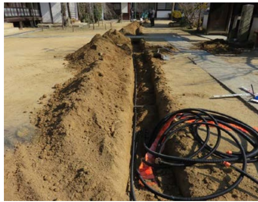
防災設備配管の敷設状況
