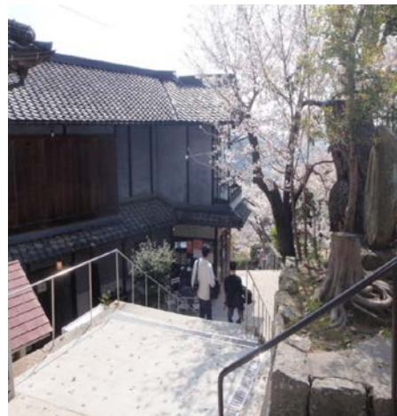
整備後 (平成29年度)
