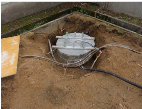
防災設備配管の敷設状況
