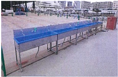
現場の手洗い場所の増設
