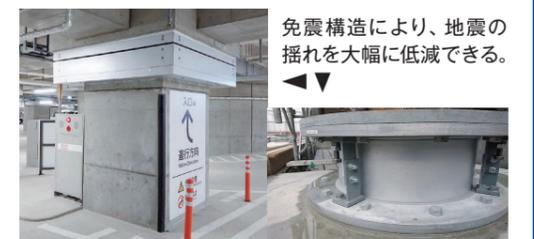
免震構造により、地震の揺れを大幅に低減できる。
