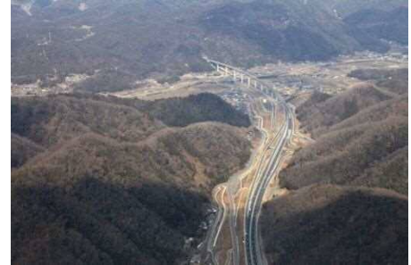
中国横断自動車道尾道松江線 尾道北 IC 付近
