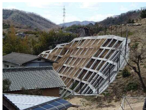
急傾斜地崩壊対策箇所
